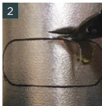
**PASO 2** Cortar con cuidado alrededor de la zona trazada. *Tomar en cuenta la traza de calor en la tubería.*
